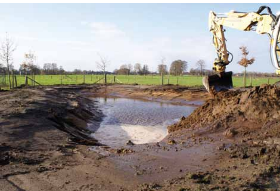
Aanleg van een poel in het buitengebied van Ede met ondiepe oeverzone (Foto: Marnix Bout)
